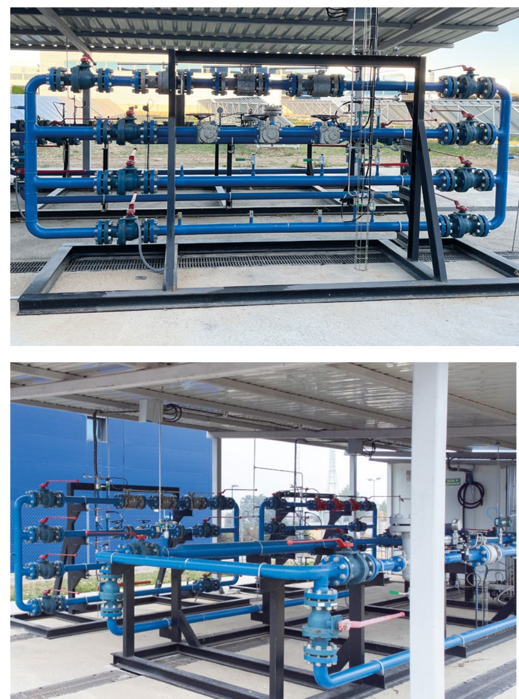
Figura 1. Plataforma de testeo estático (arriba) y dinámico (abajo) de inyección de H 2 verde a sistemas de GN. (FHA, 2023)
